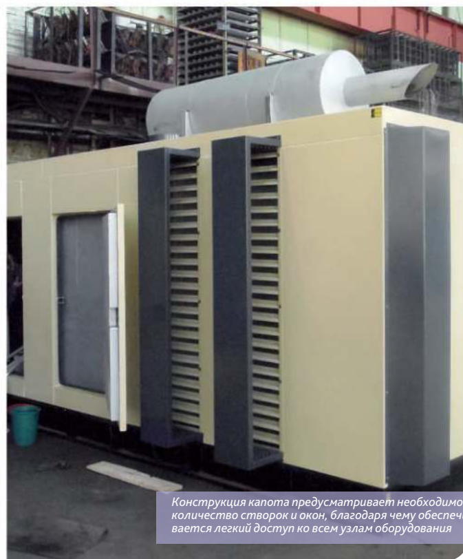
Изнутри панели капота оклеиваются специальным шумоизолирующим материалом, который гасит и шум, и вибрации от работающего двигателя
