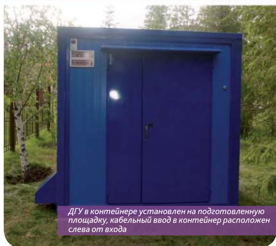
Установка ДГУ в капоте (кожухе) на бетонное основание, подключение агрегата
