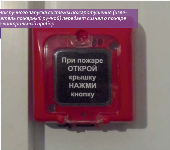
Проведение наладочных работ системы АПС, АСПТ и СОУЭ на базе прибора НПО «Болдир» (программирование алгоритма работы)
