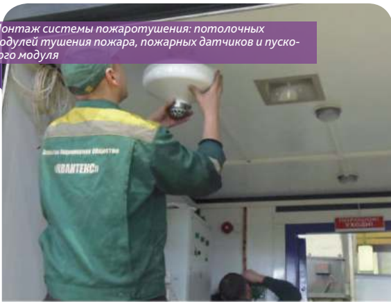
Блок ручного запуска системы пожаротушения (извещатель пожарный ручной) передает сигнал о пожаре на контрольный прибор
