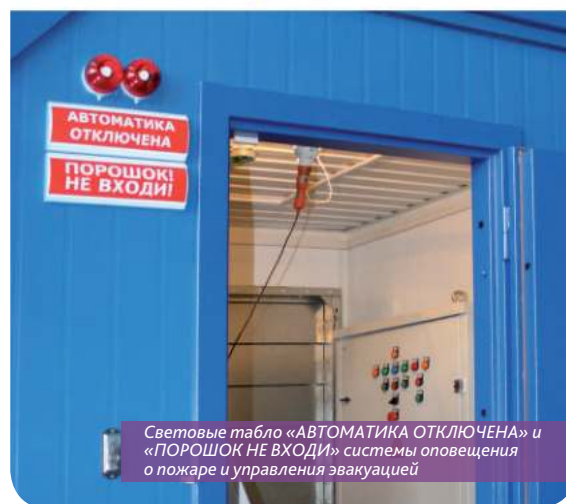
Монтаж систем охранно-пожарной сигнализации и системы автоматического пожаротушения дизельного электрогенератора
